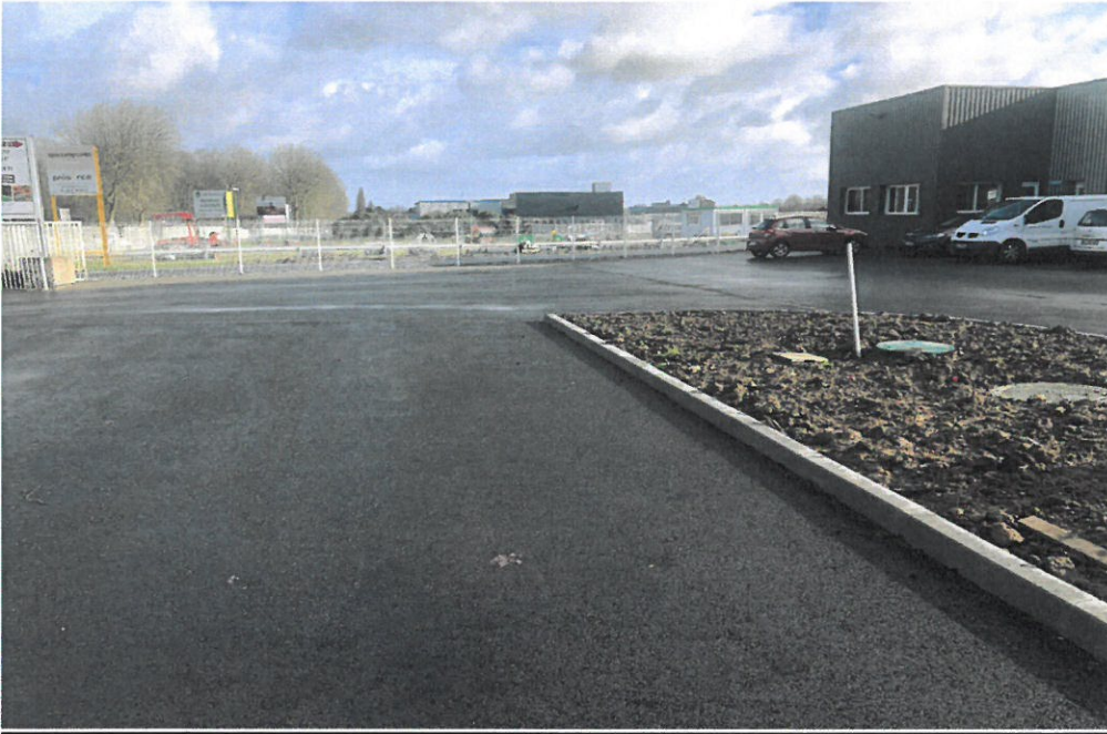
Réalisation d'un parking à Monnaie
