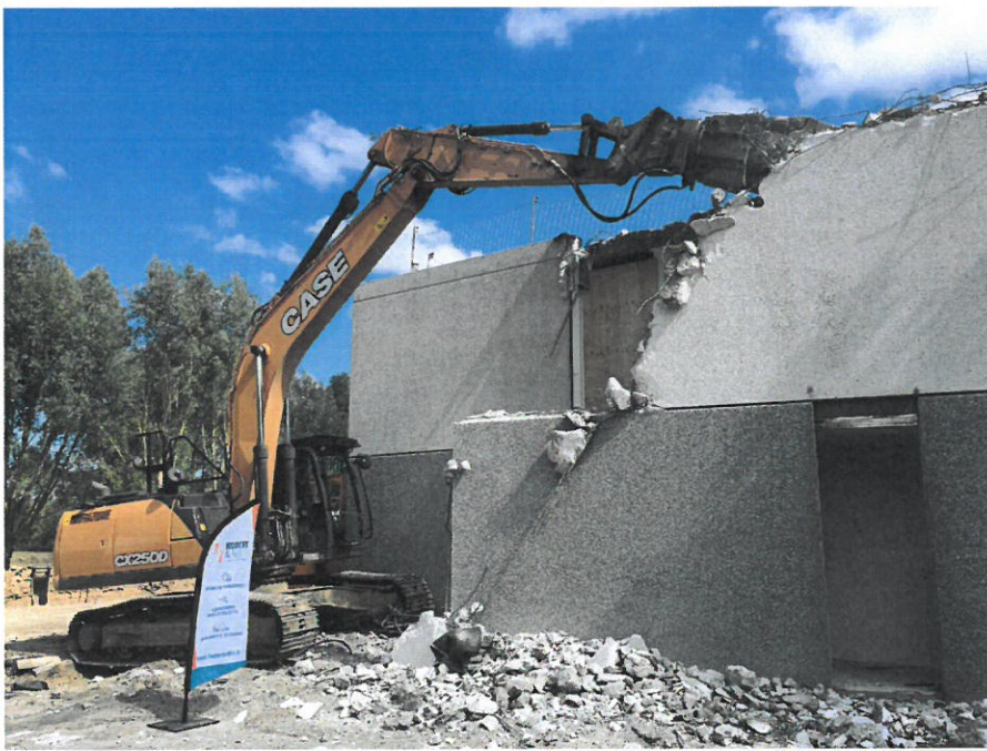
Démolition des anciens bâtiments ARTUS à TOURS
