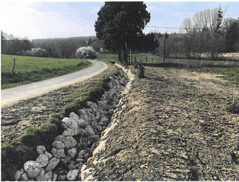
Enrochement de fossé pour la commune de SAUNAY
