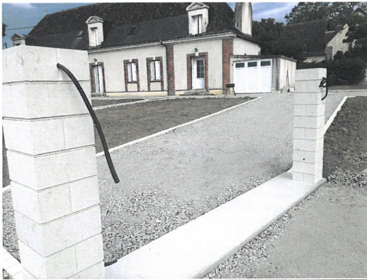
Pose de pilier et d'un seuil de portail à Crotelles
