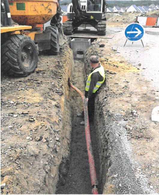
Dévoisement d'un réseau électrique pour la commune d'AMBILLOUX
