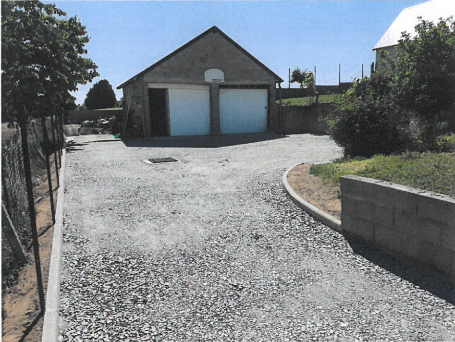
Aménagement chez un particulier avant application de l'enrobé à Bléré
