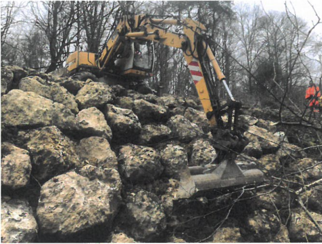
Enrochement d'un coteau pour la Mairie de Chançay
