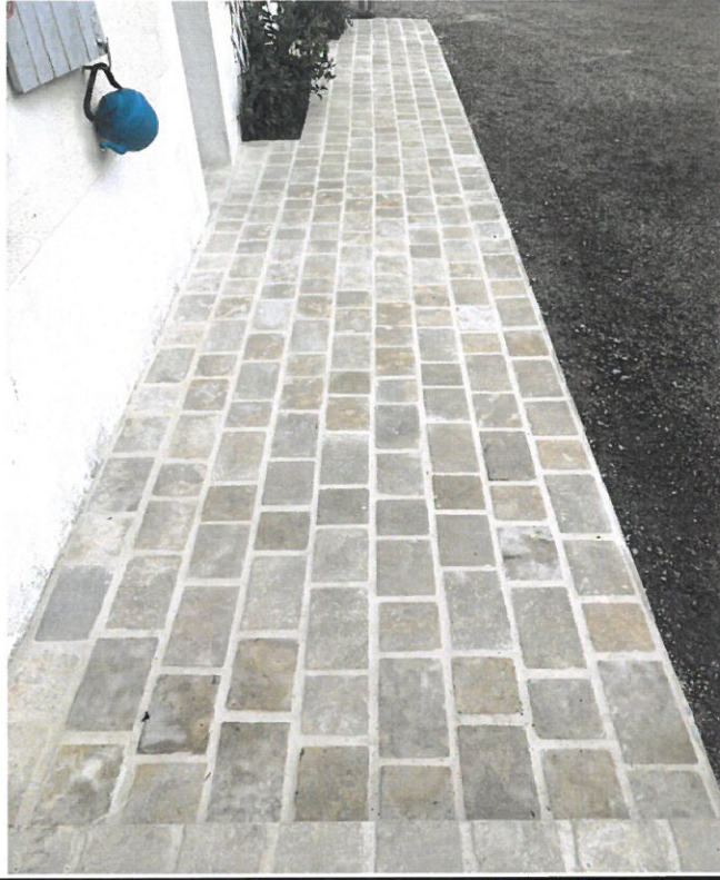
Pose de pavé Travertin chez un particulier à Crotelles
