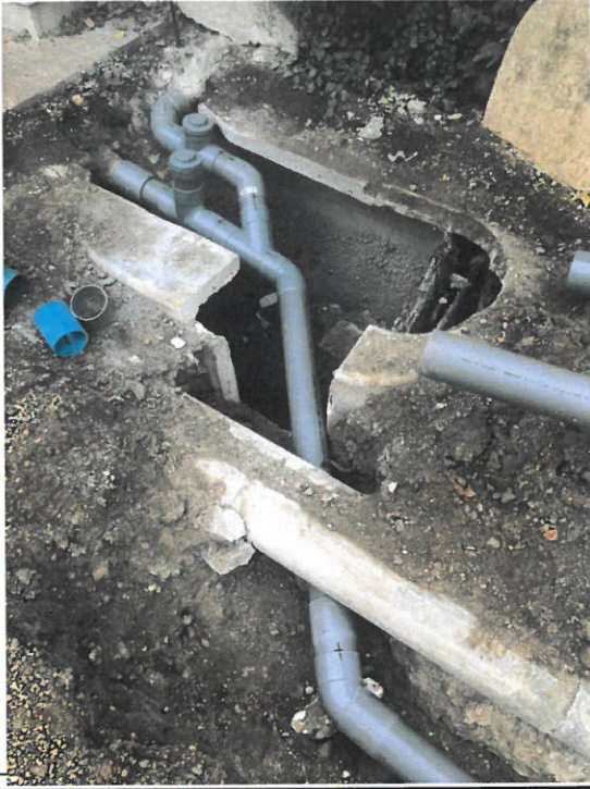
Réalisation d'une installation autonome (ANC)
