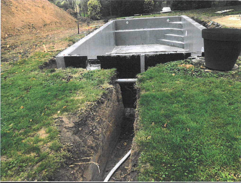
Réalisation d'un terrassement de piscine à Monnaie
