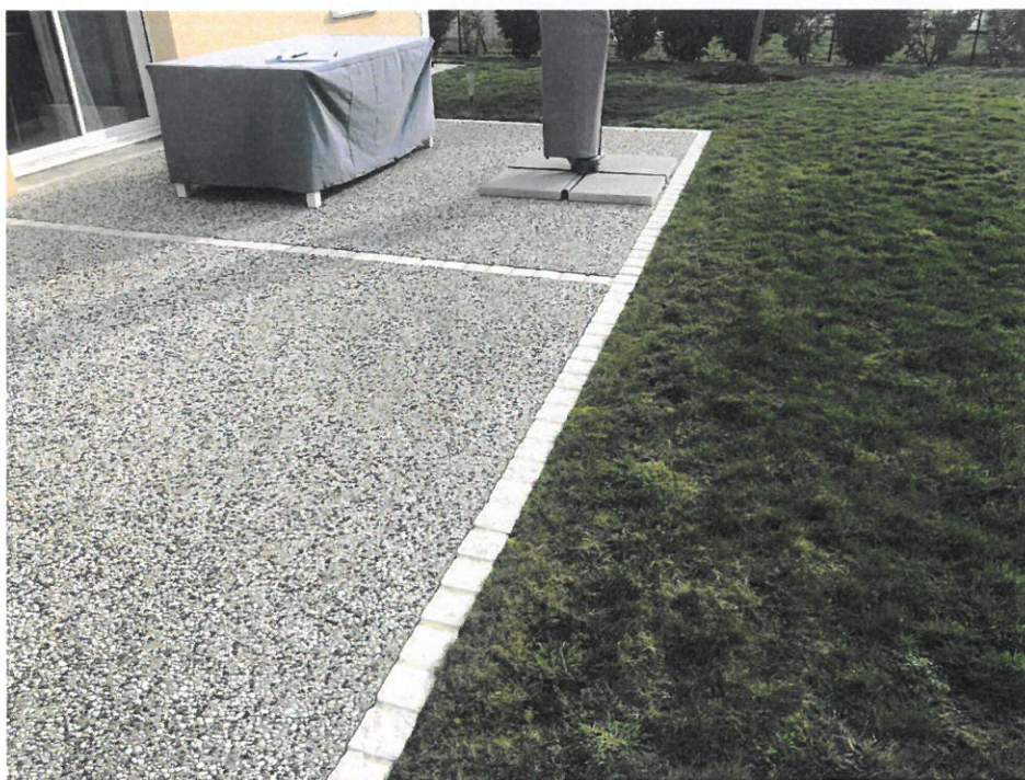
Réalisation d'une terrasse en béton désactivé
