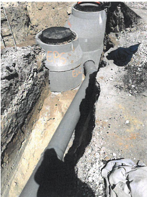
Création d'un réseau d'assainissement Ep et EU pour un lotissement de 30 parcelles à CHARENTILLY
