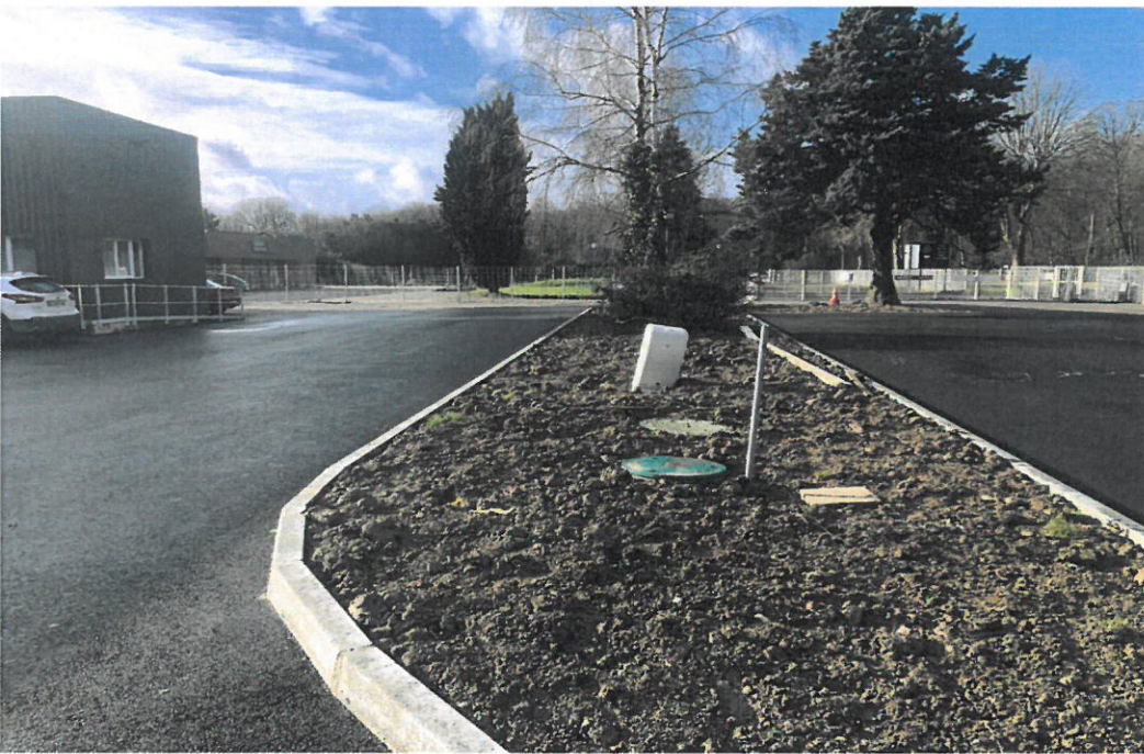
Réalisation d'un parking à Monnaie
