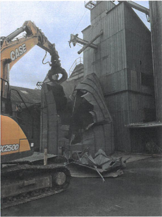
Démolition d'un Silo
