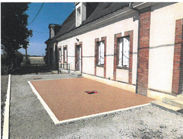
Réalisation d'une résine Hydro Way chez un particulier à Crotelles
